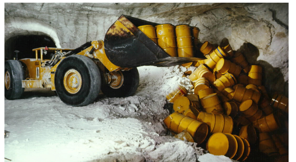
„Versturztechnik“ kurz vor Ende der Einlagerung des Atommülls 1978
