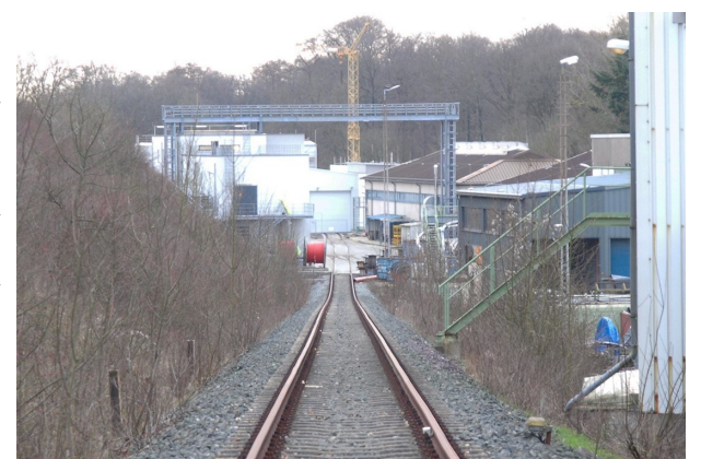
Bahngleis zum Schacht Asse II
