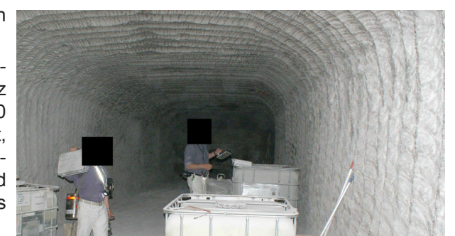
Asse II: Blick in eine Strecke des Salzbergwerkes
