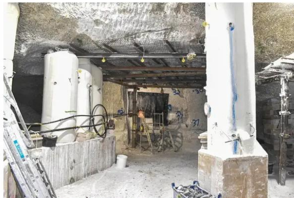
Blick auf den Arbeitsbereich, in dem die Lösung gefasst wird. Der Arbeitsbereich befindet sich am südlichen Ende des Abbaus 3/658.
