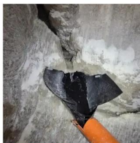
Unmittelbar, nachdem der Fließweg freigelegt wurde, konnte eine erste provisorische Lösungsfassung eingerichtet werden.
